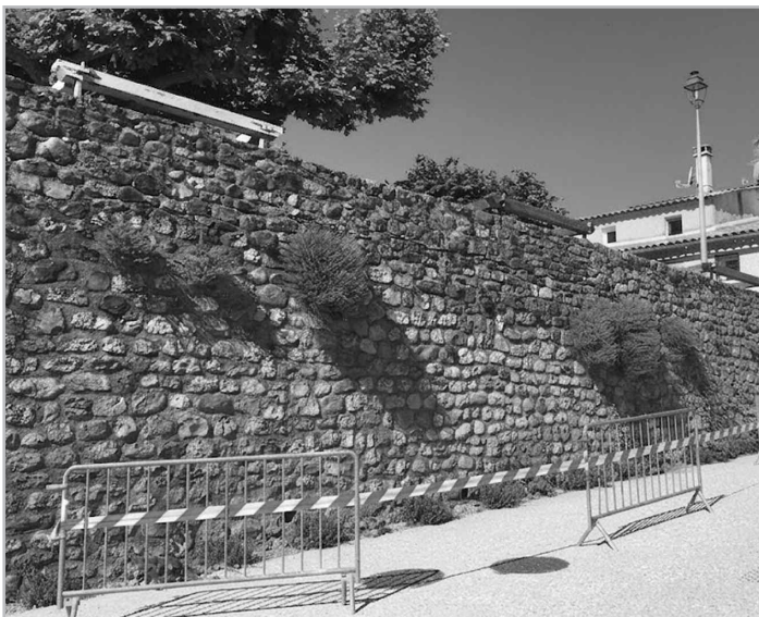
Mur de soutènement de la place Philippe Bourg - rue des écoles
