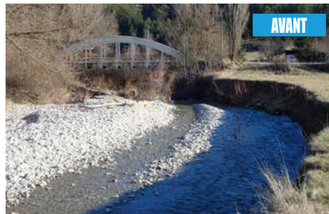
Erosion après la crue de novembre 2016, risque de contournement du pont
