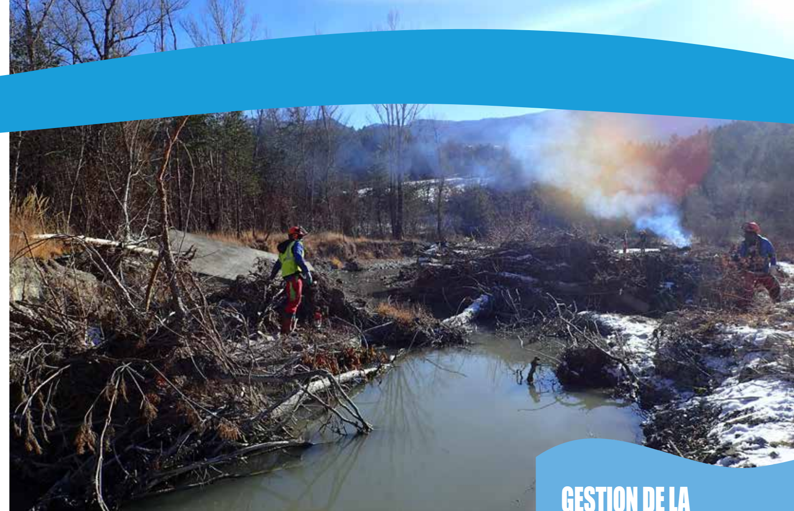
Enlèvement d'embâcles dans le lit de la Méouge
